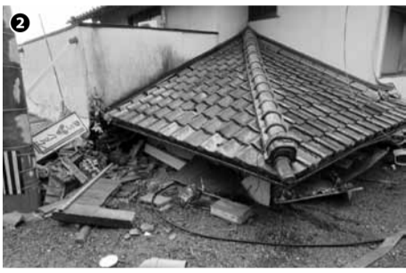
①この地域では、竹を縛り縫った木舞(小舞)を柱と梁の間に下地を作り、土を塗り、しっくい仕上り土壁の住宅も多い。筋交いはなく、地震の揺れに対しては弱い。②1階部分が座屈した住宅③波打つ路面
