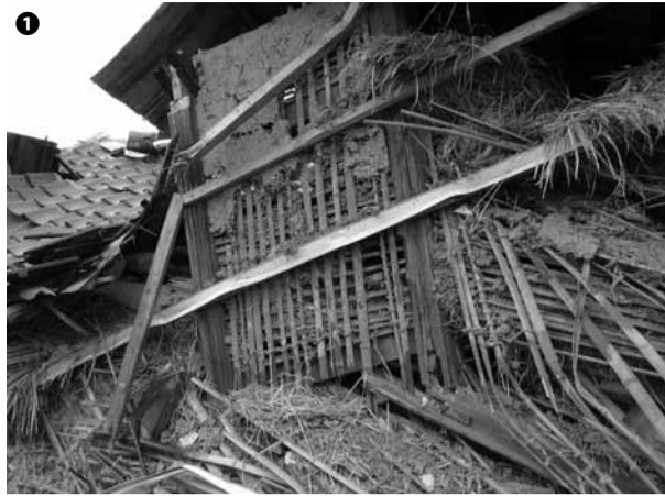
①この地域では、竹を縛り縫った木舞(小舞)を柱と梁の間に下地を作り、土を塗り、しっくい仕上り土壁の住宅も多い。筋交いはなく、地震の揺れに対しては弱い。②1階部分が座屈した住宅③波打つ路面
